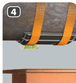
4 ROLLERKIT® soldado en frío en la tubería
