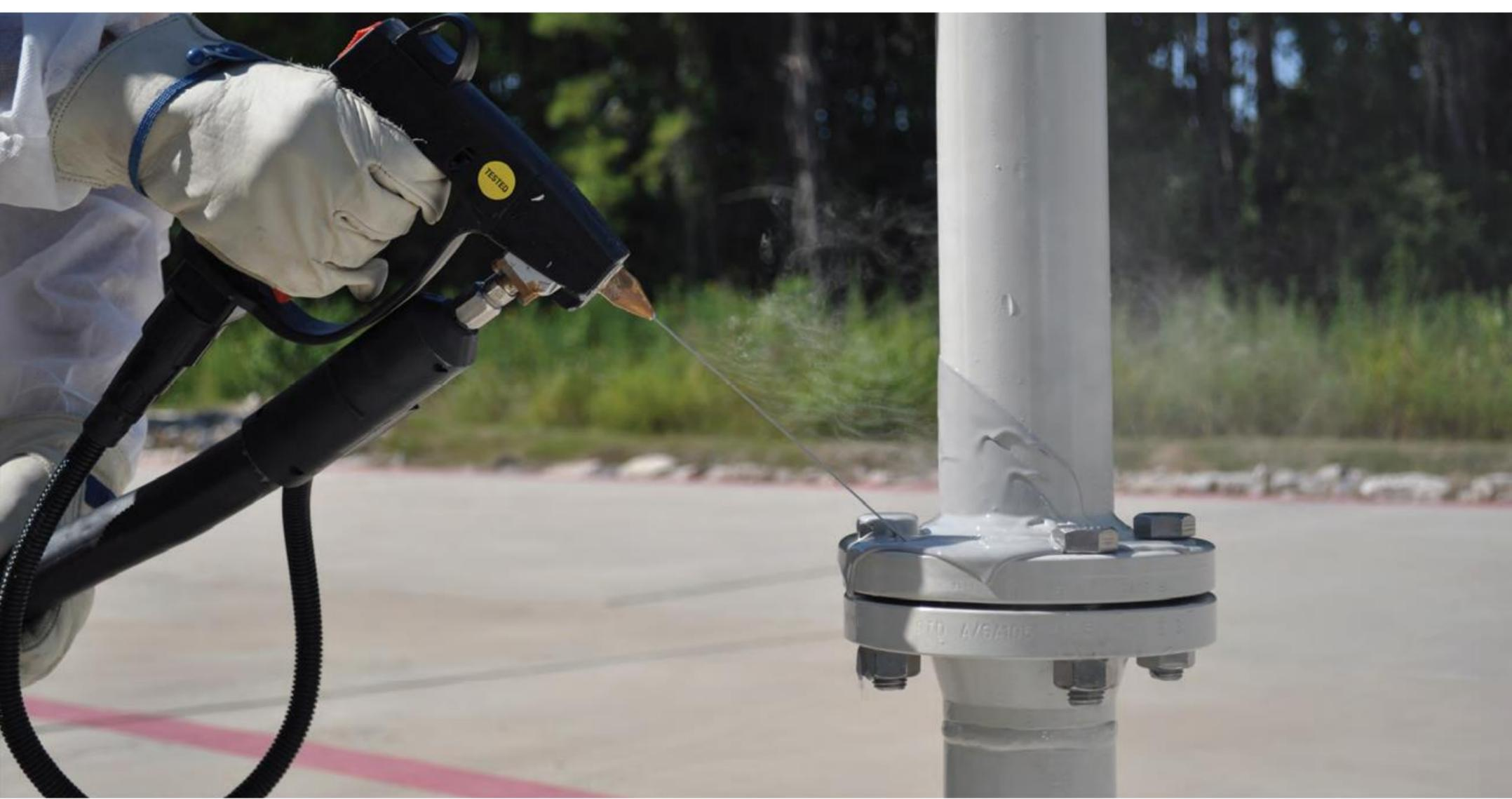
**OXIFREE®** es un sistema de recubrimiento termoplástico para la protección de componentes metálicos. Contiene inhibidores de corrosión orgánicos, los cuales encapsulan la pieza y actúan como una barrera secundaria para la entrada de agua u otros contaminantes.
